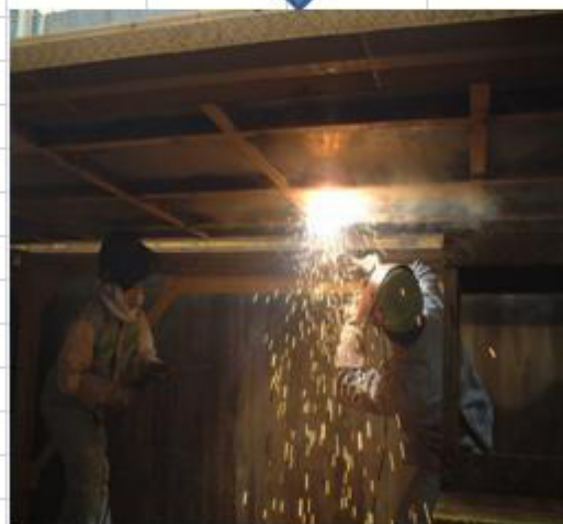
パレット溶接
