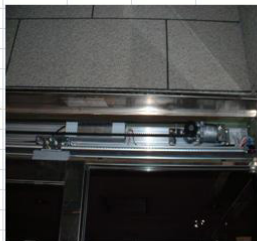
エンジン側装置改造後
