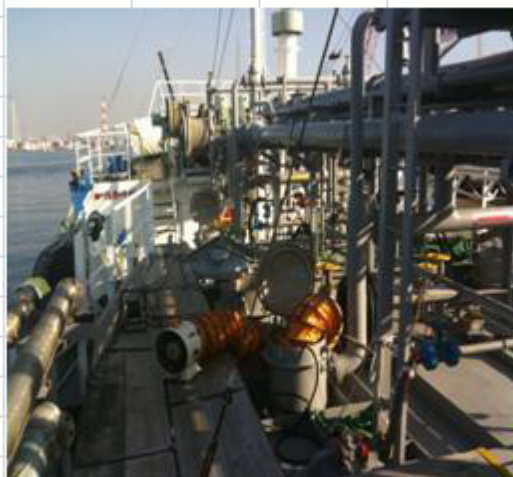
タンク内部の作業前
