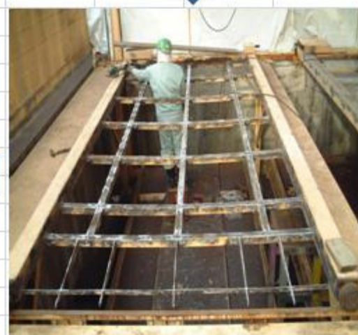
骨組みの点検
