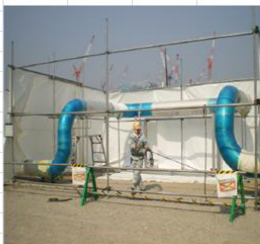
現場にての配管組立溶接作業
