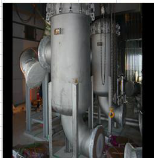
フィルターユニット屋内設置
